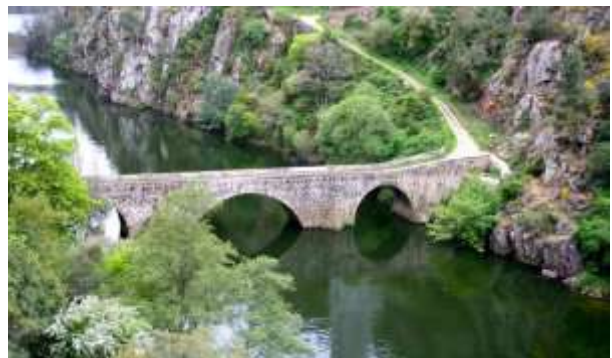
Figura 6. Ponte do Cabril (ponte filipina) de Pedrógão Pequeno (Fonte: ADXTUR, 2013).
