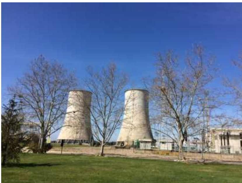
Figura 8. Torres de refrigeração na Central Termoelétrica do Pego (Fonte: Autores, 2019, com autorização da Central Termoelétrica do Pego).
