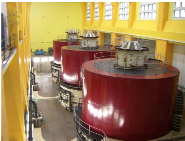
Figura 2. Três turbinas tipo Francis da barragem de Castelo do Bode (Fonte: Marques: 2010).
